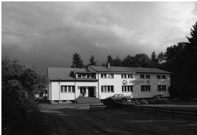
Ryc. 1. Budynek Stacji Badawczej PZŁ w Czempiniu (fot. H. Mąka)
